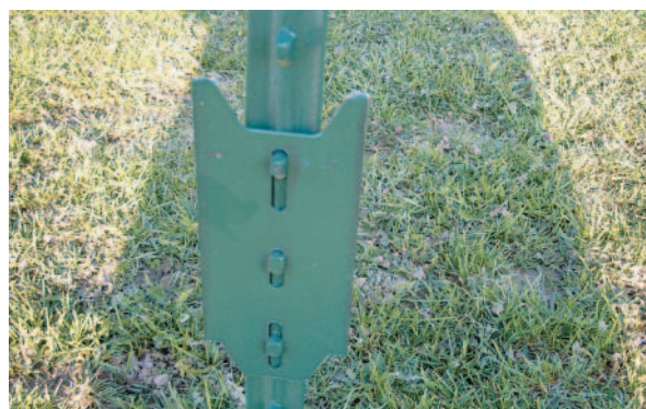
Bild 1: Ankerplatte am T-Pfosten zur Erhöhung der Standsicherheit
