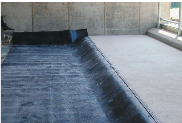
Bild 2 und 3: Einbau Agrotel Comfortex Kuhmatratze, Verlegen der Doppelschläuche
