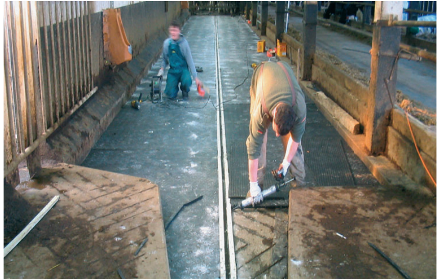
Bild 2: Verlegen Agrotel Soft Car Mat
