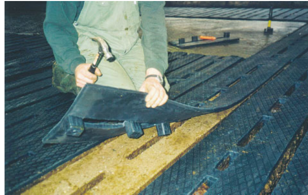
Bild 2: Verlegen des EasyFix™ Spalten- bodensystems
