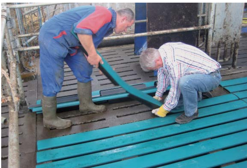
Bild 2: Verlegen Comfort Slat Mat
