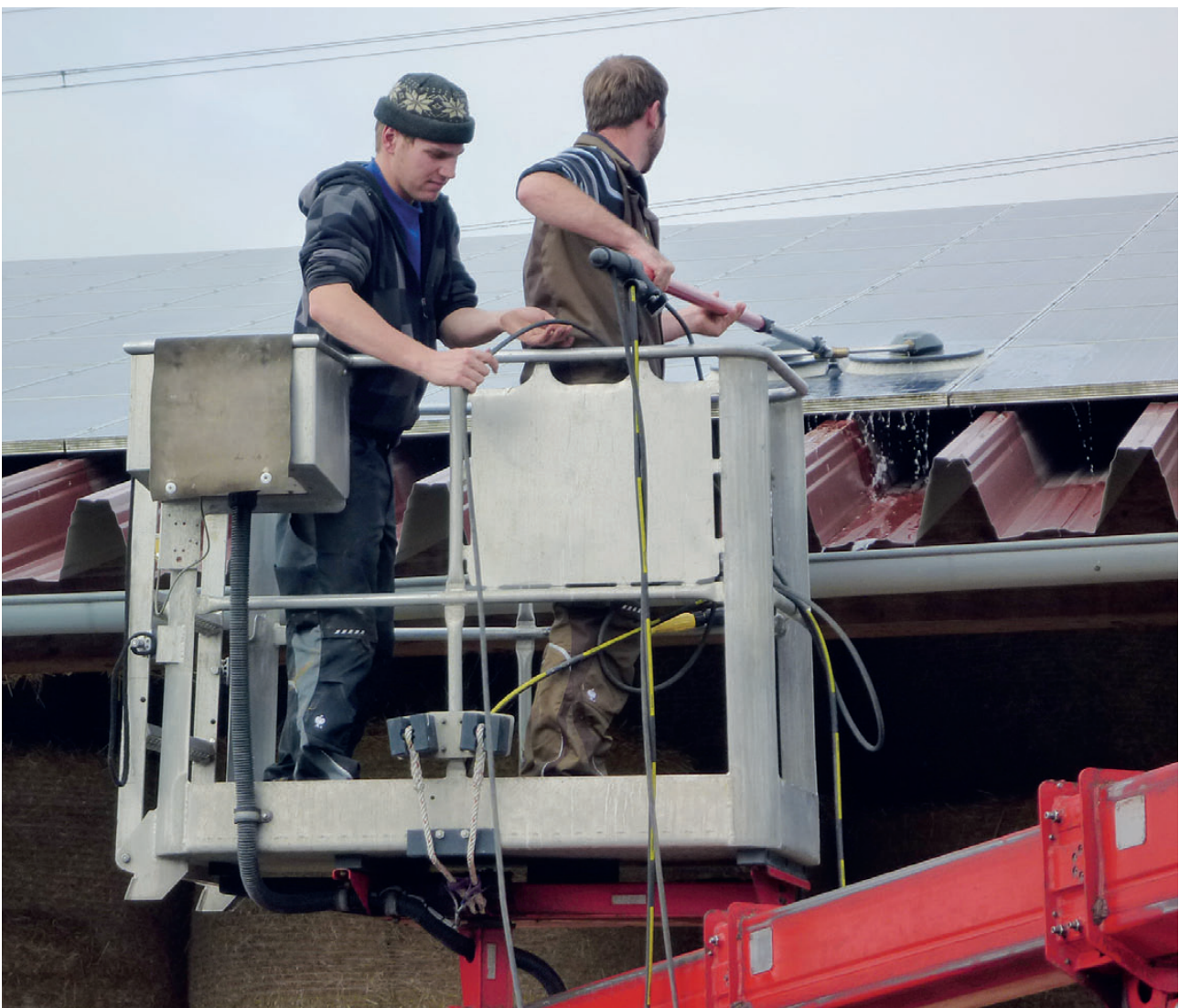
Bild 7: Reinigung aus dem Hubsteiger nach oben mit zwei Personen
