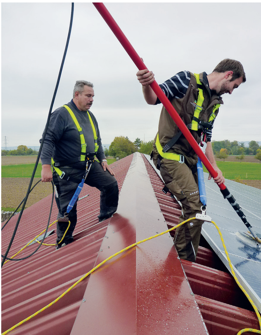
Bild 8: Reinigung auf dem Dach stehend nach unten mit zwei Personen
