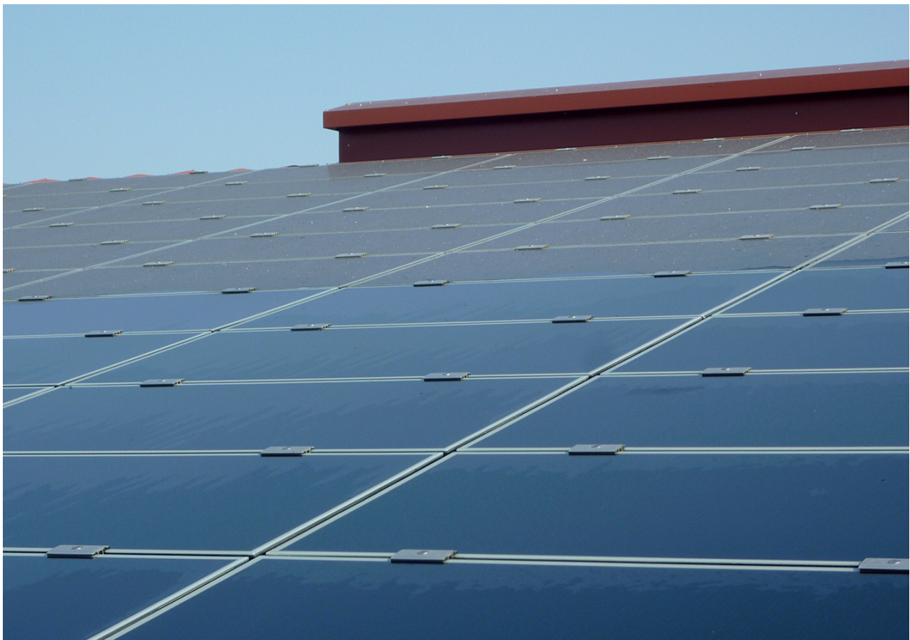
Bild 6: Vergleich zwischen gereinigten Modulen (untere Reihen) und ungereinigten Modulen (obere Reihen) auf Praxisbetrieb 2
