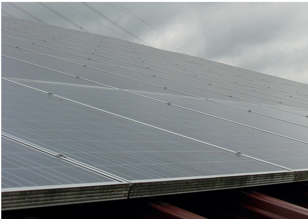
Bild 5: Vergleich zwischen gereinigten Modulen (untere Reihe) und ungereinigten Modulen (obere Reihen) auf Praxisbetrieb 1
